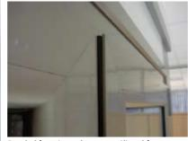
Posición de microventilación.
